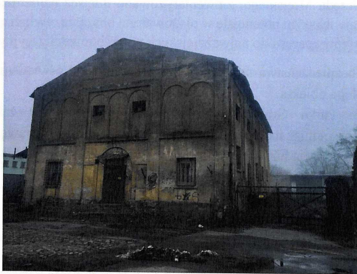
Fotografia 9 – Budynek dawnej synagogi w Grabowie
